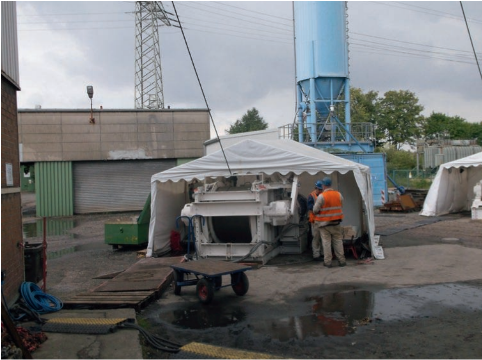
Einrichten der Baustelle – Situation über Tage
