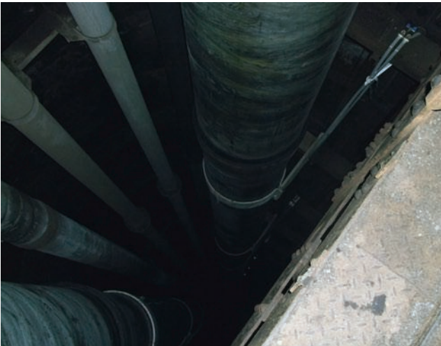
Fertig eingebaute Hüllrohre mit Halterung
