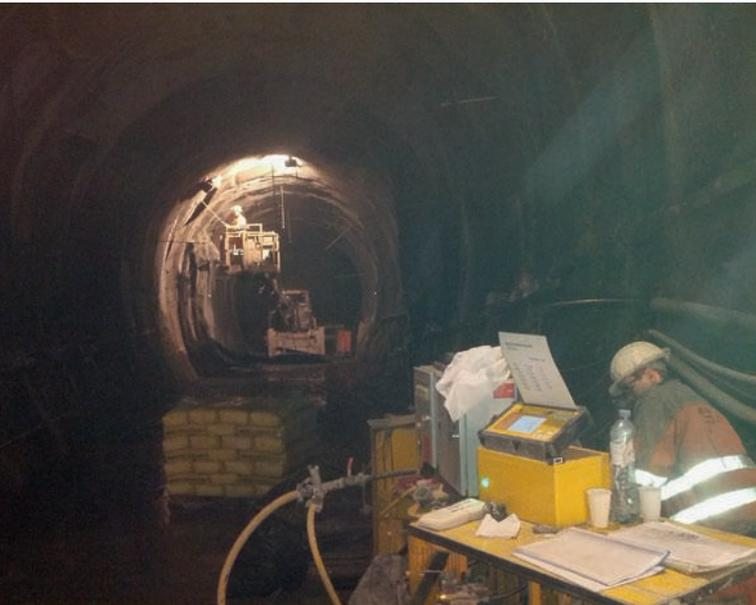
Injektionsaufzeichnung und Injektion in einem Triebwasserstollen
