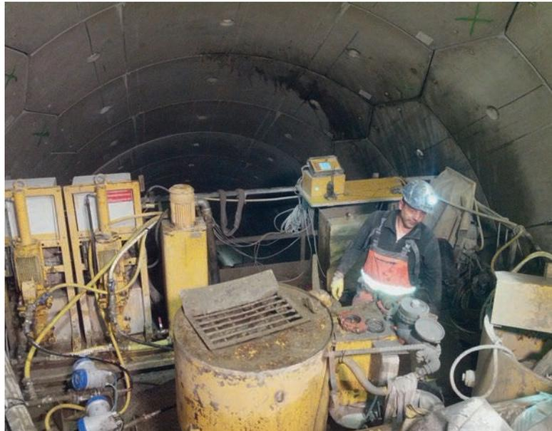
Injektion im Schrägschacht durch die Beton-Tübbinge
