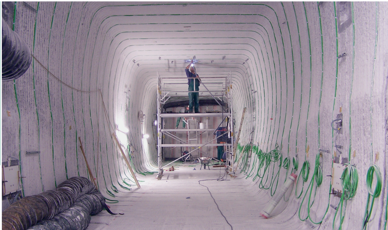
Einbau der Mess- und Injektionstechnik
