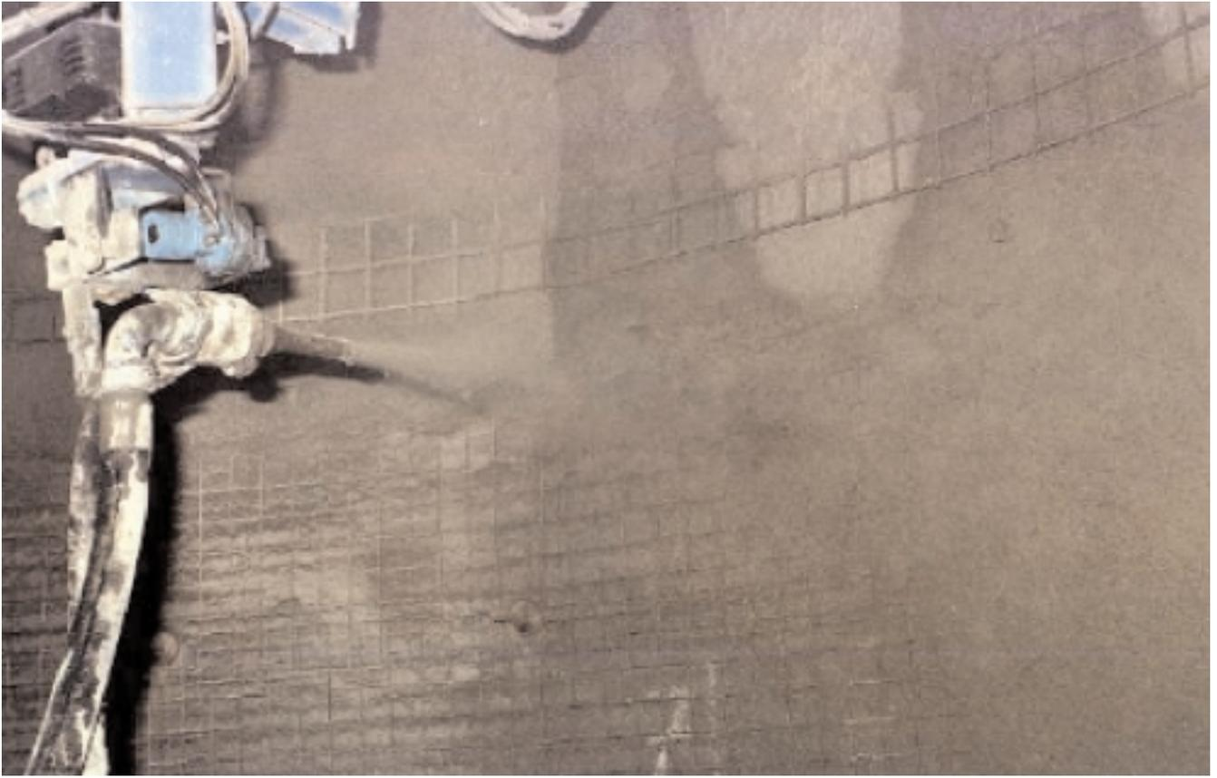
Primsmulde: Auftragen des Spritzbetons auf den vorläufigen Ausbau
