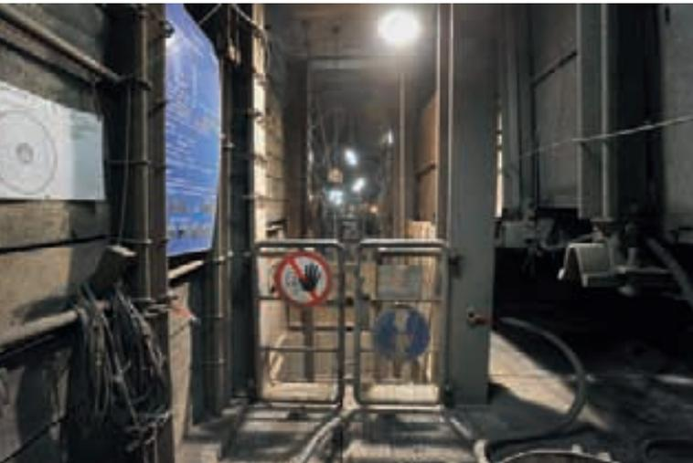
Eingang zum tiefgesetzten Korbaufstieg für die Bunkerbefahrung, rechts Bandstraße mit Stahlverkleidung für den Sprengschutz
