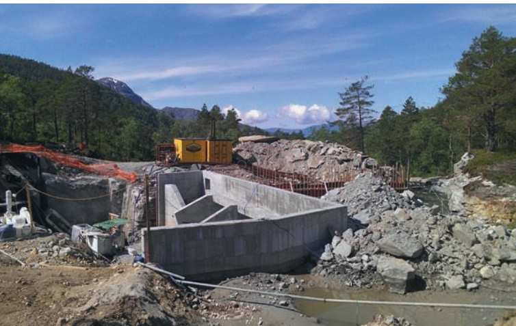
Стройплощадка Торснес, верхний бьеф и водоприемник
