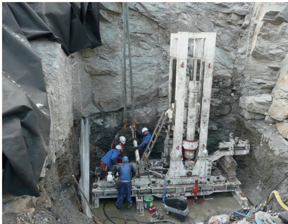
Монтаж опрокидывающего пневматического цилиндра HG 160/2
