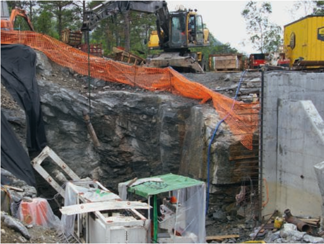
Подъем установки расширительного бурения
