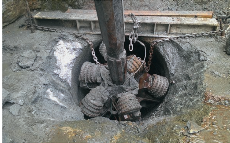
Успешная сбойка головки установки расширительного бурения
