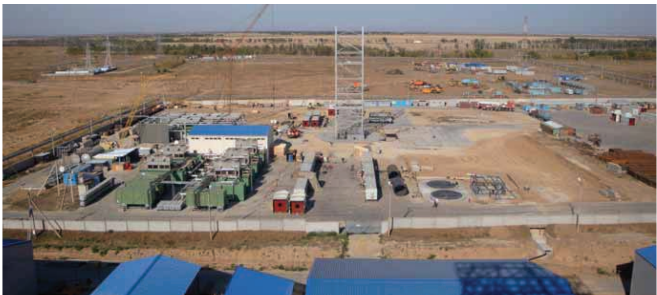
Blick auf den Schachtplatz
