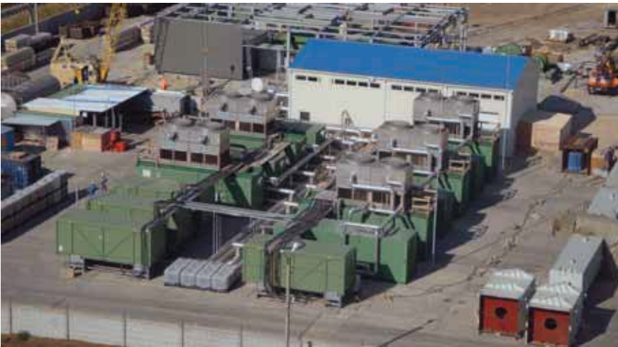
Gefrieranlage für Schacht 2
