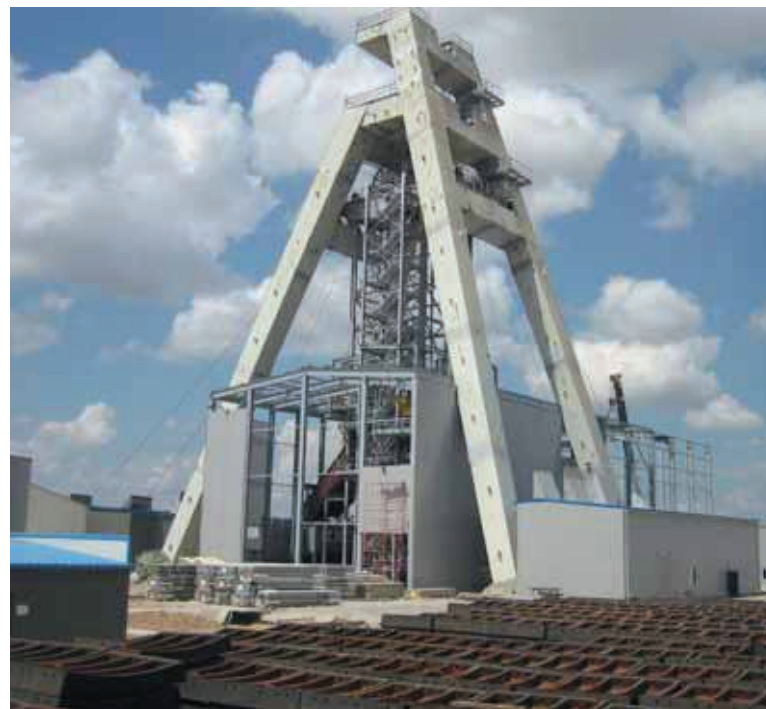
Fördergerüst auf Schacht 2
