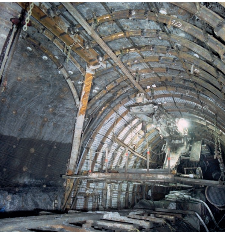
Abzweig-Polygonträger mit Ausbaubögen
